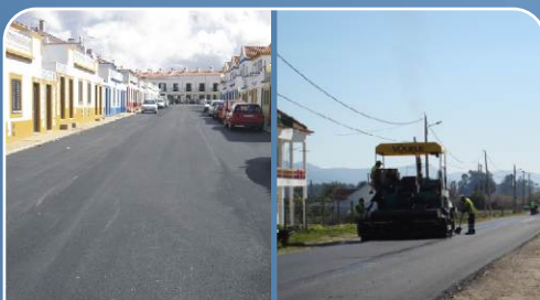
V.N.MILFONTES - REPAVIMENTAÇÃO DO CM1072
