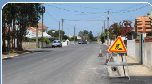
GALEADO - ARRANJO DE PLUVIAIS E REPAVIMENTAÇÃO DA EM532 ATÉ S. LUIS
