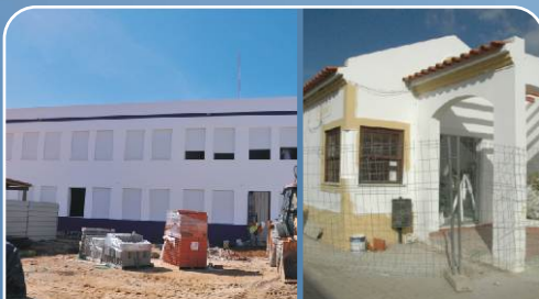
V. N. MILFONTES - NOVO EDIFÍCIO NA ESCOLA E REMODELAÇÃO DO POSTO DE TURISMO
